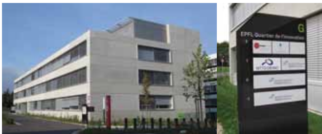
日東電工ヨーロッパテクニカルセンター外観
