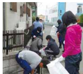
側溝の清掃。 津波のヘドロが溜ったままに なっており、除去した。
