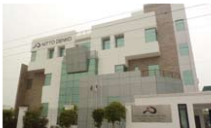
2009年11月に設立した日東電工インドの建物
