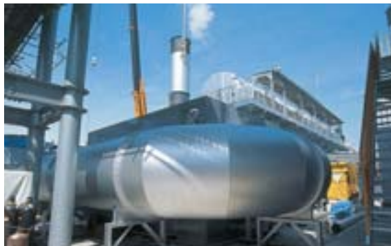
尾道事業所で建設中の新脱臭炉
