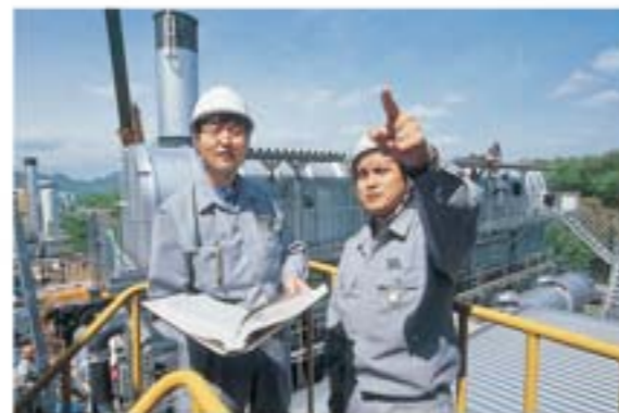
建設中の脱臭炉の前で
